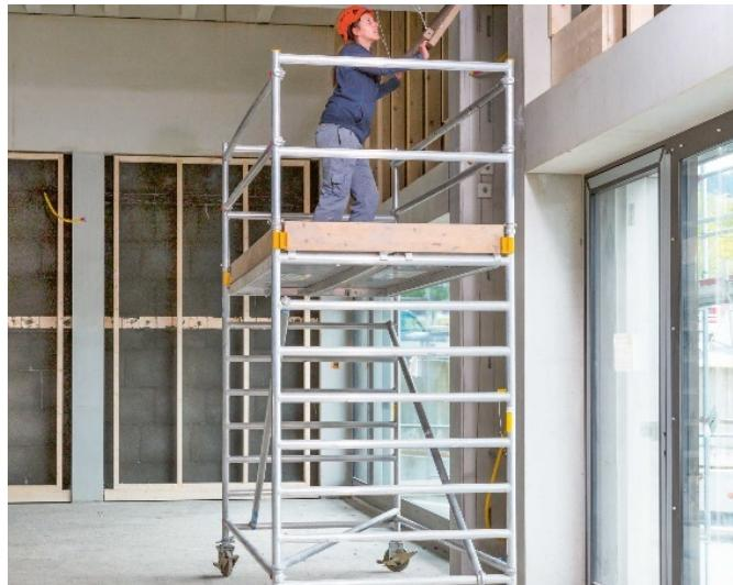
**Arbeitnehmer:** Ich arbeite in der Höhe mit einem sicheren Gerüst. Fehlt das sichere Gerüst, spreche ich das Vorgehen mit meinem Vorgesetzten ab.
