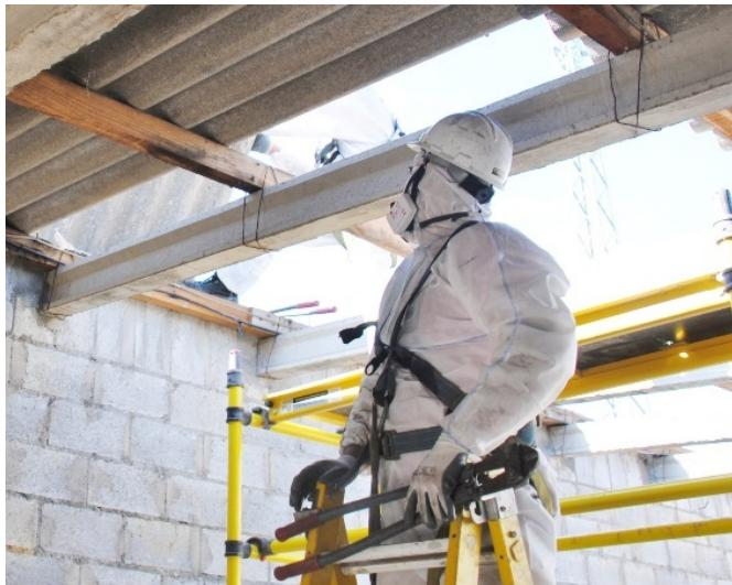
**Arbeitnehmer:** An asbesthaltigen Materialien arbeite ich nur nach genauer Instruktion und mit den notwendigen Schutzmassnahmen.
